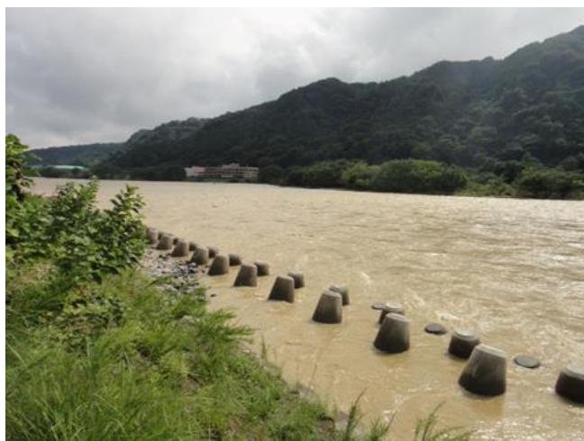
図 1. 台風で増水した相模川・大島付近.
