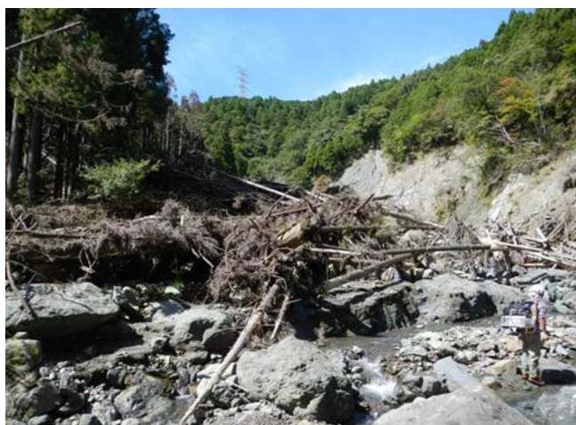
図 2. 台風で崩落した丹沢・酒匂川の源流.
